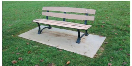
Un banc rénové en 2021 : assise et dossier en matériau composite, pieds en fonte restaurés, dalle de propreté en béton.
